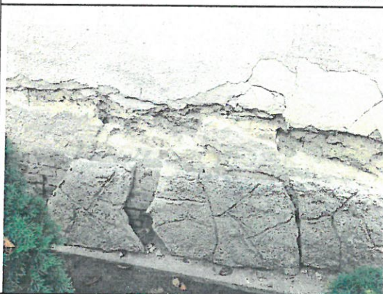
A szomszéd felőli homlokzat
