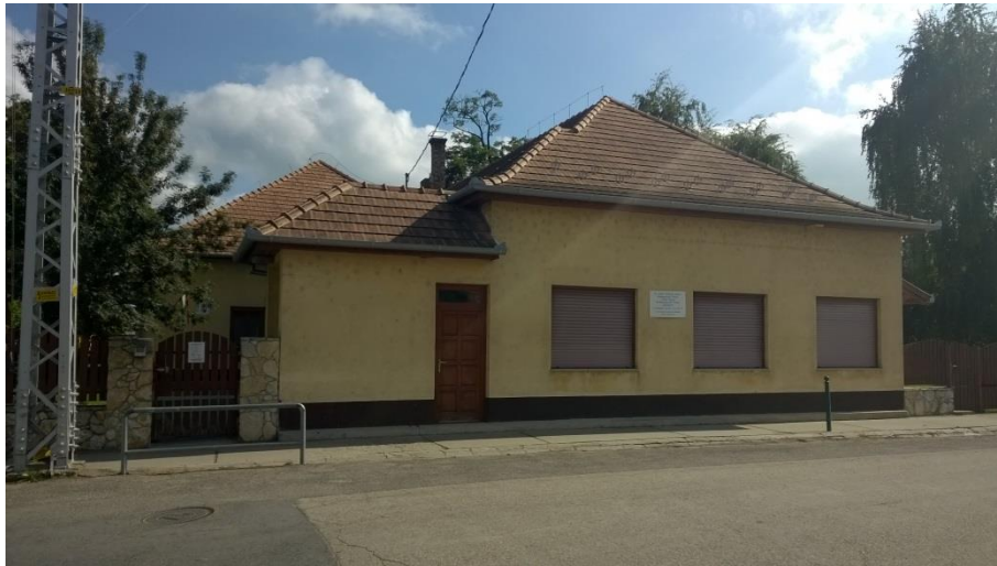
A meglévő óvoda épülete
